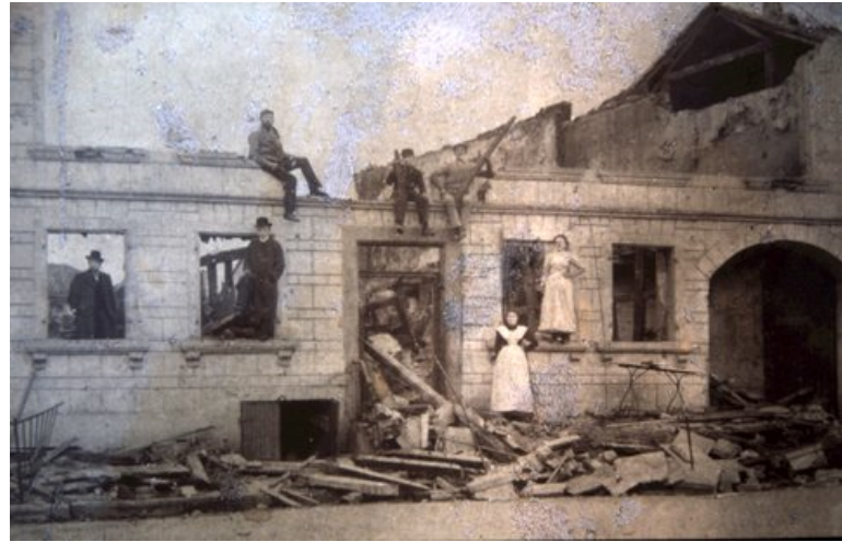
Der Brandschaden des Hotel Schumacher 1903
