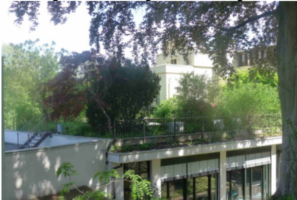
Abbildung 2: Verbindungsbau mit Dachgarten
